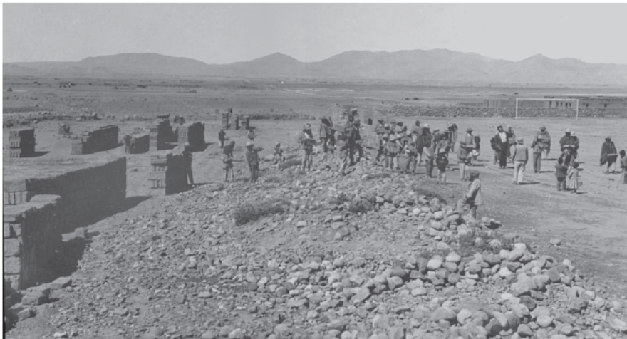
Iniciando la construcción del Pabellón México: limpieza del terreno y fabricación de adobes. (1934).
