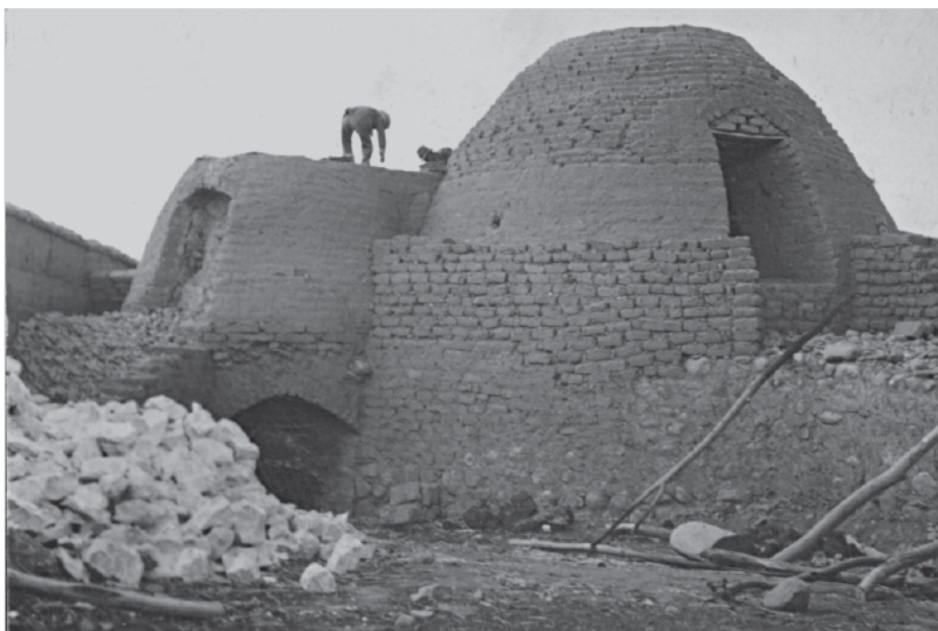
Hornos para ladrillos y tejas, contruidos por Raúl Pérez en Warisata. (1939)
