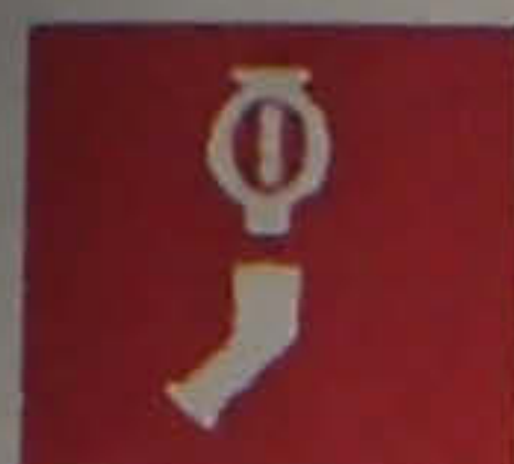
CONEXIÓN SIMPLE PARA ROCIADORES AUTOMÁTICOS
